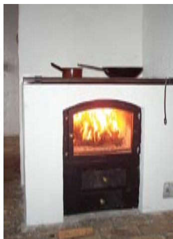
Muret brændekomfur med kogeplader og bageovn.
