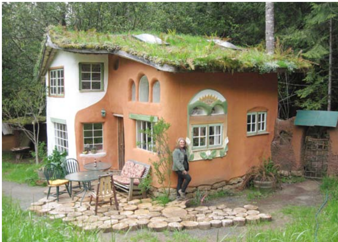
Linda Smiley foran The Heart House på COB Cottage Company, Oregon. www.cobcottage.com Huset er bygget af COB med ler- & kalkpuds. Lokal energi fra bl.a. raketovn. Komposttoilet og rensning af spildevand. Vand fra lokal kilde. Genbrugsvinduer/døre
